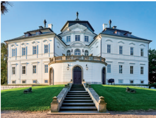
Pałac Karlova Koruna
